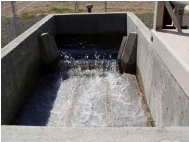
Figure 8B–8 Flat over pour screen Othello, WA
